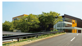
福岡センター外観
